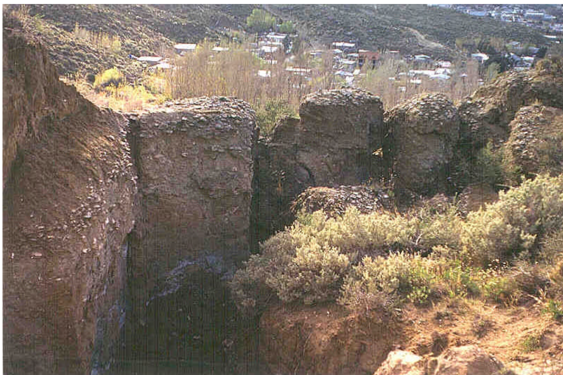
Foto 14: Bloques separados por fracturas de tracción afectados por la expansión lateral.
