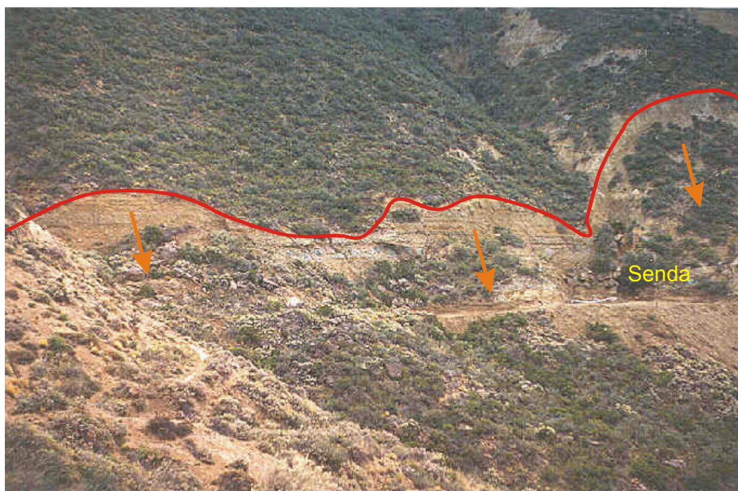
Foto 22: Evidencia de deslizamientos rotacionales por encima de la senda.
