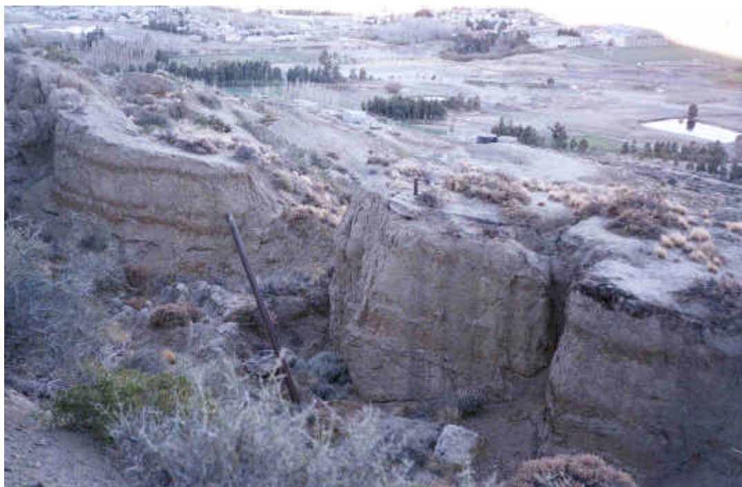
Foto 11: Bajos y grietas en el material movilizado.
